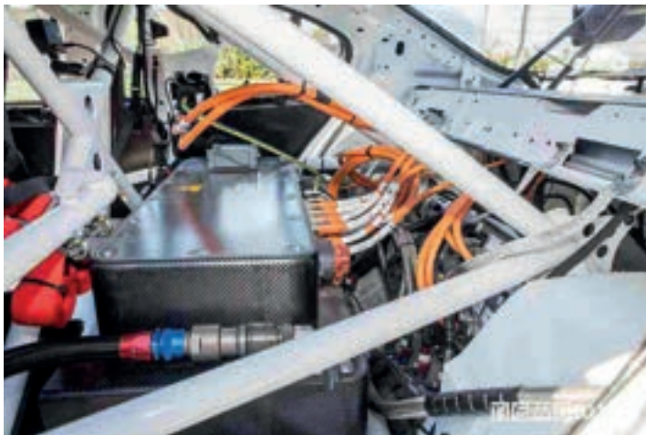
Inverter nell'abitacolo della Giulia ETCR by Romeo Ferraris
